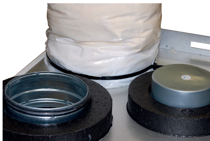
Joonis 6. Paigaldatud kanal
