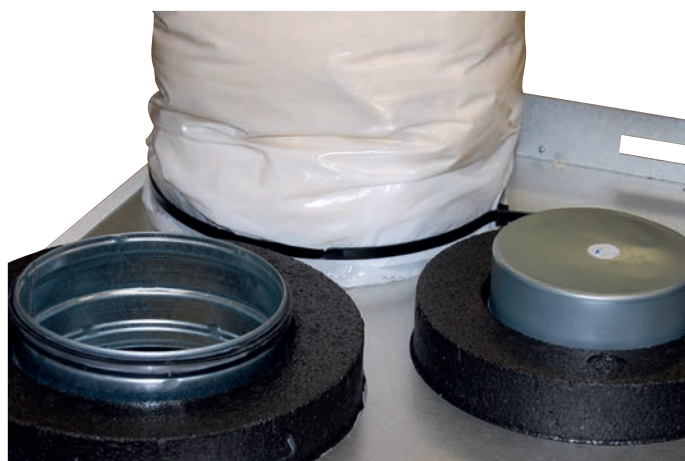
Joonis 21. Paigaldatud kanal
