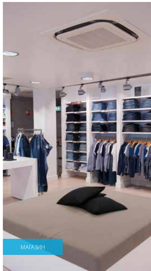
Кассетный круглопоточный тип FXFQ-A: Распределение потока воздуха на 360° для оптимальной эффективности и комфорта
